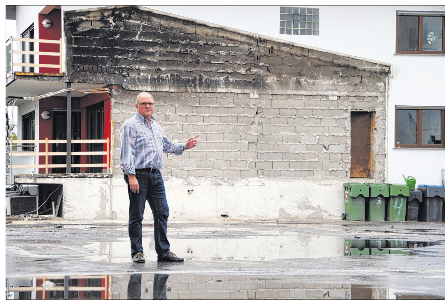
Schreinermeister Markus Kleinhans (50) steht an dem Ort, an dem sich bis im Juli noch seine Produktionshalle befunden hatte. Ihre Umriss lassen sich noch gut am angebauten Bürogebäude erkennen. An gleicher Stelle entsteht bald eine neue, ebenfalls 1200 Quadratmeter umfassende Halle. Der Bauantrag ist gestellt, Anfang Oktober rechnet Kleinhans mit dem »Roten Punkt«. Wenn alles nach Plan läuft, steht Ende des Jahres der Rohbau, sodass im Januar mit dem Schließen der Wände begonnen werden kann. Im Februar sollen dann die Maschinen einziehen, um im April wieder mit der Produktion beginnen zu können. Foto: Martin Egg
